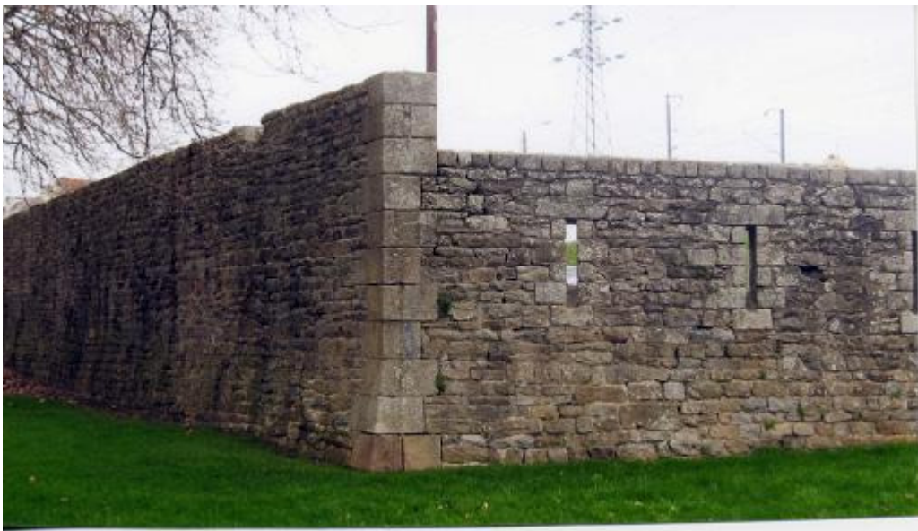
Vue extérieure de la redoute-batterie Photo C. Le Colleter
