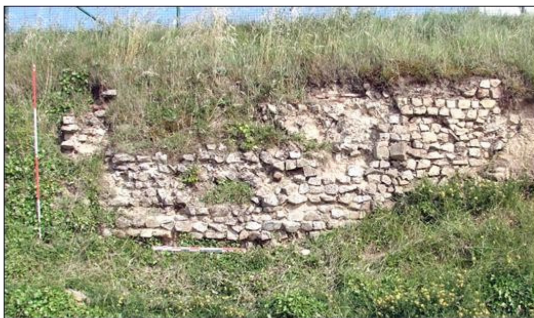
Figure 2 : Murs visibles en front de falaise
