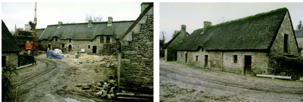
Le site en plein chantier et les premières restaurations. Déjà les maçonneries ont été consolidées, les charpentes reprises, les toitures de chaume refaites à l'ancienne. (Photos Gaby Le Cam)
