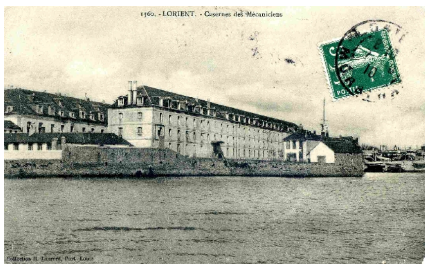
L'Ecole des Mécaniciens (ancien baigne). A gauche : l'ancienne batterie de la Tourmente
